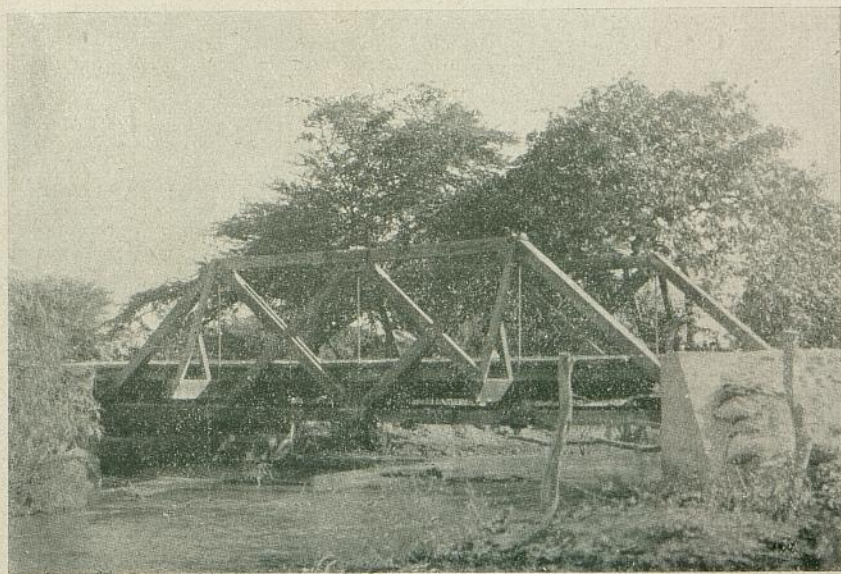
Tipo de puentes de madera, construídos por la Comisión de Irrigación, para luces pequeñas.
