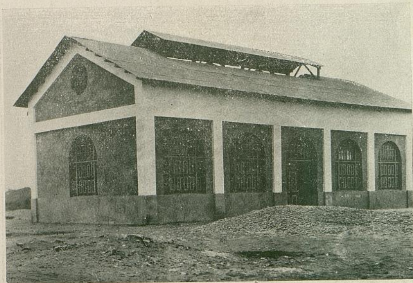
Planta Eléctrica de la ciudad de Lambayeque, construida por la Comisión de Irrigación.
