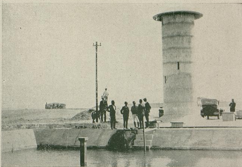
Torre de presión, para la cañería de conducción del agua potable de Paita. Obras de Irrigación del Gobierno del Perú.
