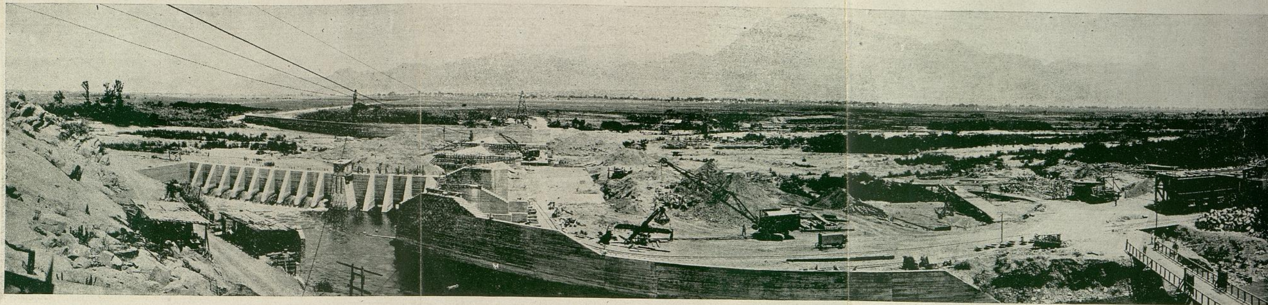
La Toma de la Punilla, sobre el río Chancay, (Lambayeque), con la cual la Comisión de Irrigación, a la vez que capta las aguas para el regadío de las nuevas tierras, ha asegurado el riego de las tierras en actual cultivo, y ha puesto al valle entero a cubierto del peligro de inundaciones como las del año 1925.
