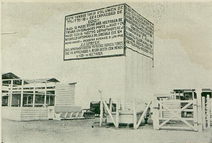
Tanque erigido en los terrenos de la Exposición, para vulgarizar el concepto de la unidad o módulo de riego establecido en la nueva reglamentación de la distribución de aguas en Lambayeque.
