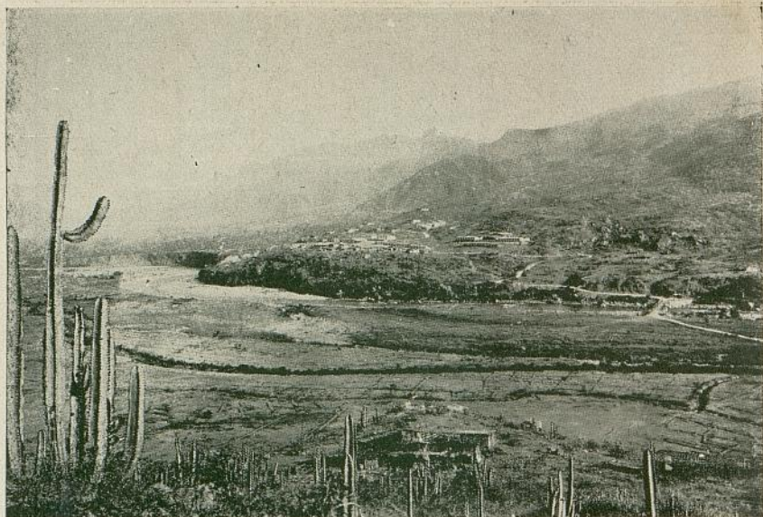
Campamento de Carhuaquero, sobre el río Chancay, y sitio de la Represa de Carhuaquero.
