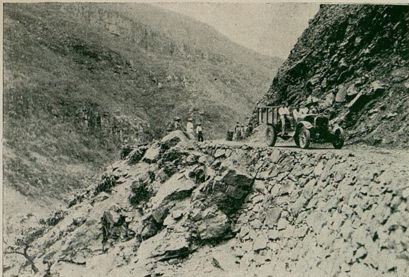
Los trabajadores indígenas son muy expertos en la construcción de "pilcas" o muros de sostenimiento de albañilería de piedra seca.
