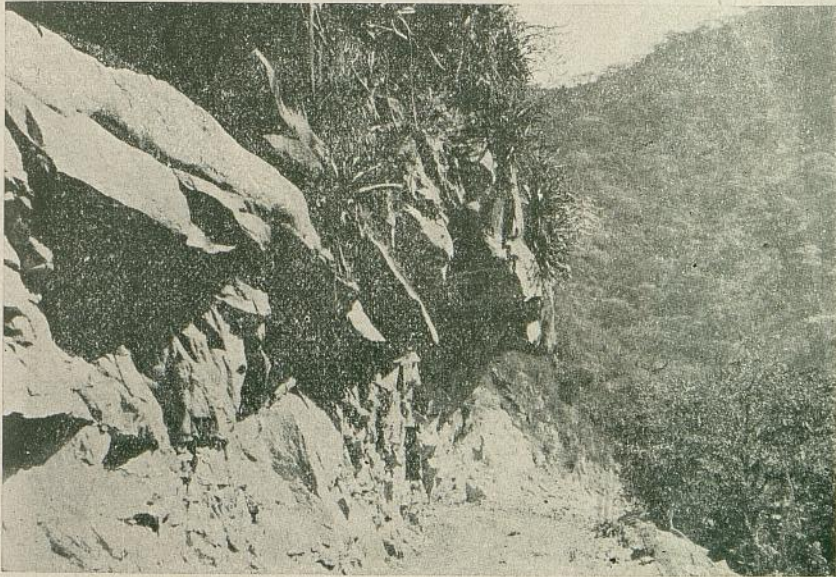
Zona difícil, en roca, en el mismo camino.
