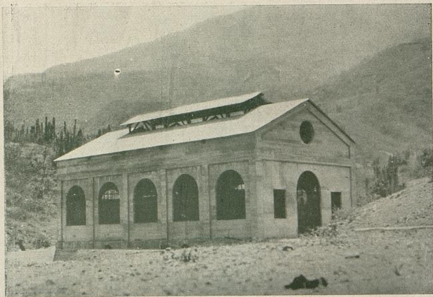
Casa de Fuerza de la Planta Eléctrica de Carhuaquero.
