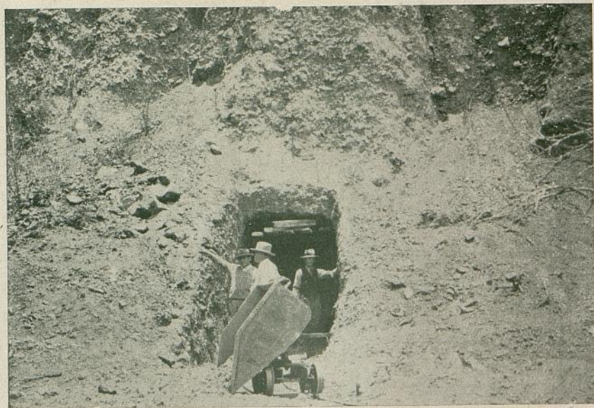
Material arcilloso que servirá para la construcción de la Represa de Carhuaquero. Obras de Irrigación del Gobierno del Perú.
