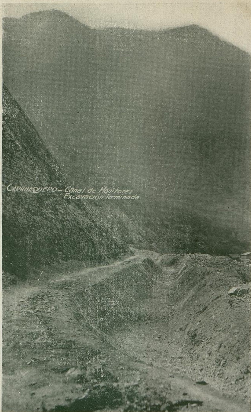
Canal de monitores, de 17 kilómetros de largo, Carhuaquero. Obras de Irrigación del Gobierno del Perú.
