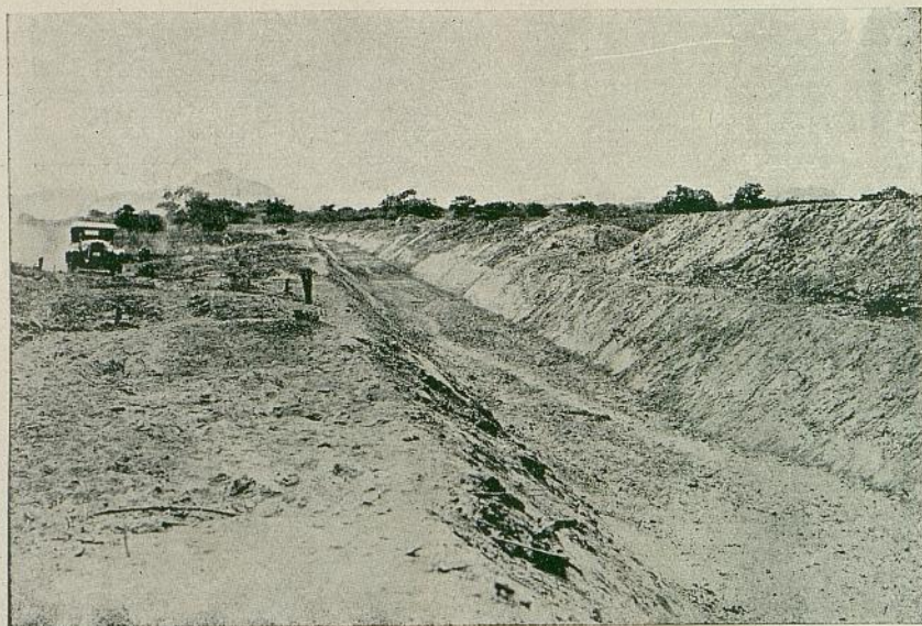
Excavación de la prolongación del Canal del Taymi.
