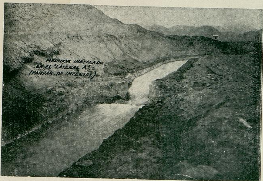
Medidor "Venturi Flume" instalado en el Lateral "A". (Pampas del Imperial).
