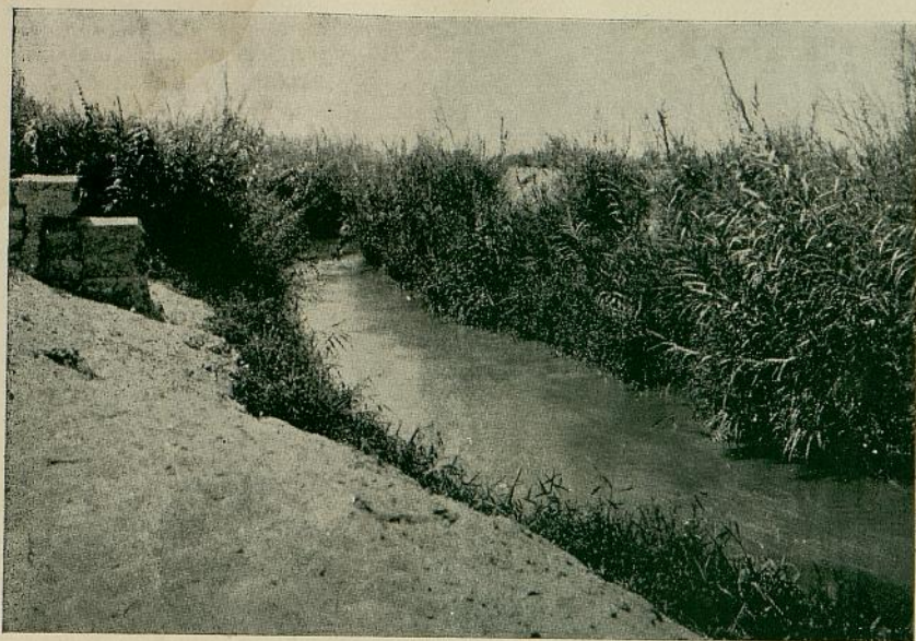
Canal "San Miguel", Cañete.—Aspecto típico de los canales de Cañete, después de 5 meses de limpiados, mostrando la sedimentación y la abundante vegetación.
