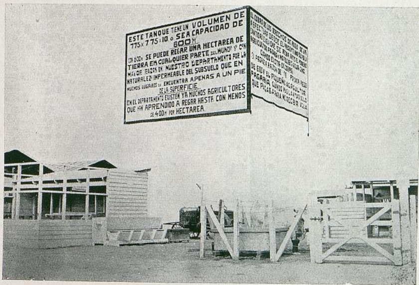
Tanque que representa un volumen de 600 metros cúbicos, que es el tipo de riego del nuevo sistema de distribución de las aguas.
