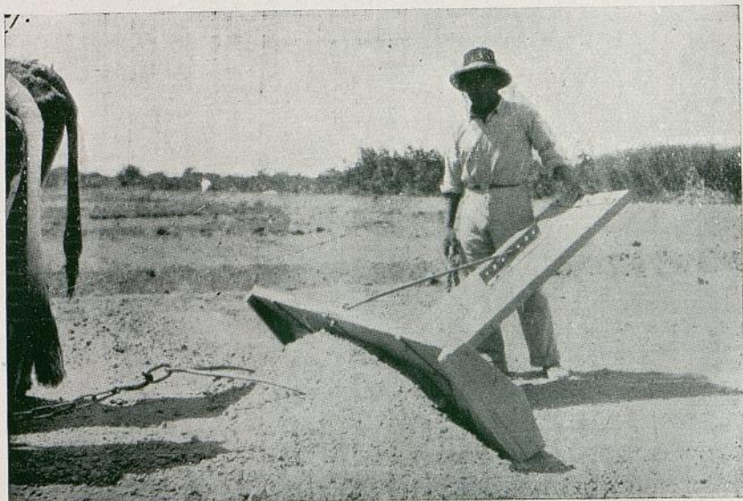
Fig. 6.—Lampón nivelador, en posición de descarga.
